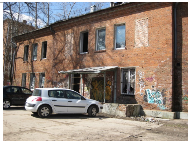
Фото №2. Фасад здания
